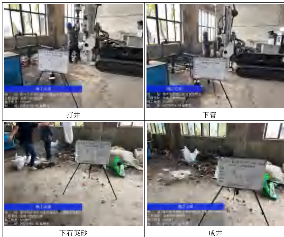
图4.2-2 监测井安装过程
