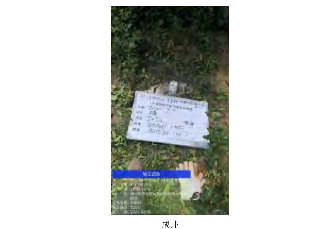
图4.2-2 监测井安装过程
