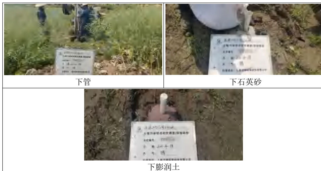
图4.2-2 监测井安装过程
